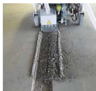
Oszillierendes Fräsen = geringes Betriebsgewicht
