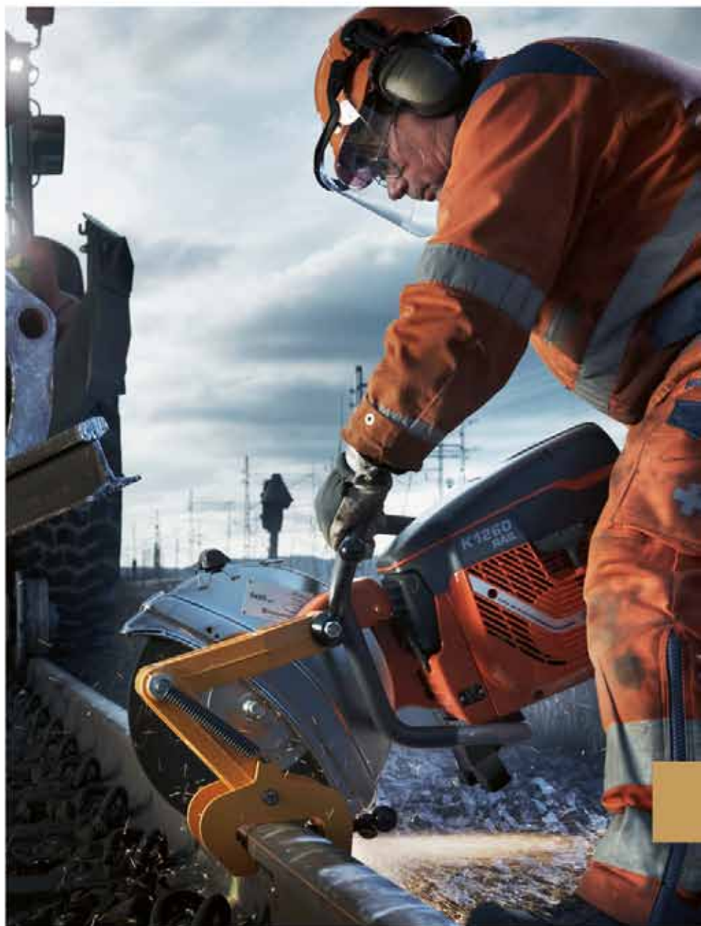
Rychlé a stabilní namontování přídatného zařízení na kolejnici.
