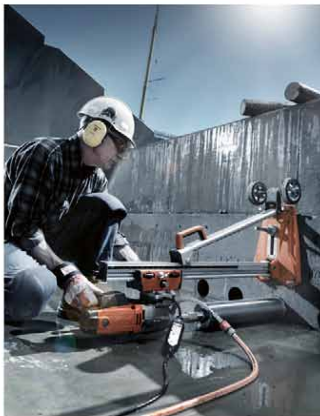
Prodloužení pro vrtání blubokých otvorů pomocí standardních vrtáků.
