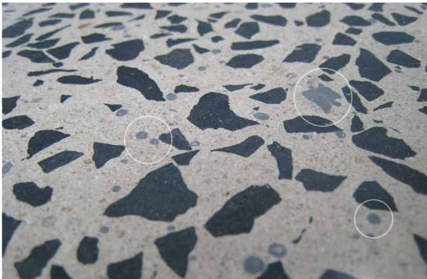
Otvory vyplněny při broušení diskem o zrnitosti 120 s kovovou vazbou a GM 3000™.
